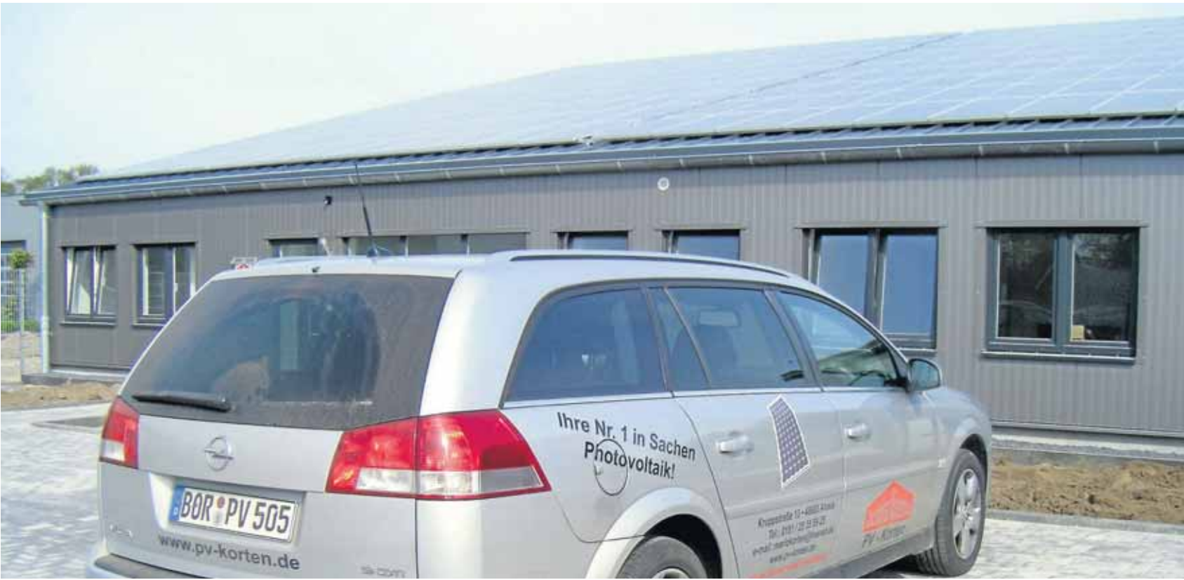
PV-Korten ist die Nummer eins in Sachen Photovoltaik. Da die bisherigen Räumlichkeiten in Legden zu klein geworden waren, erfolgt nun der Umzug in das neue Betriebsgebäude samt Photovoltaikanlage auf dem Dach an der Kruppstraße in Ahaus – einschließlich einer Ausstellung mit Modulen und Wechselrichtern. MLZ-Foto
